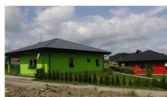
SÝTE FAREBNÉ FASÁDY DOMOV / Nežiadúce
