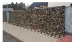
VYSOKÝ GABIONOVÝ PLOT / Nežiadúci
