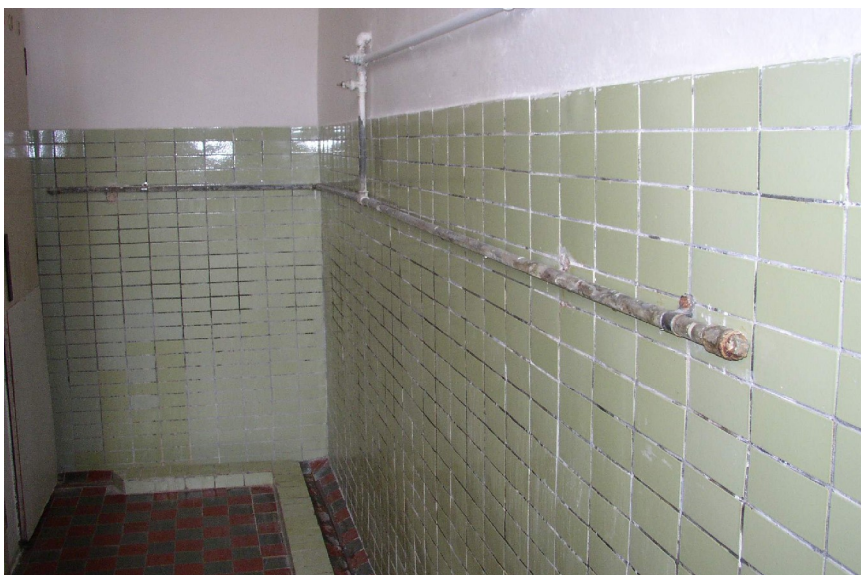
Keramické obklady, nevyhovujúce pisoárové stánie
