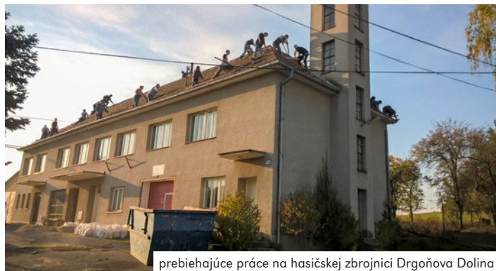
prebiehajúce práce na hasičskej zbrojnici Drgoňova Dolina
