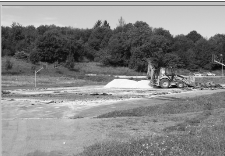
Výstavba viacúčelového ihriska v športovom areáli na Hurbanovej ulici za začala 18. augusta.
