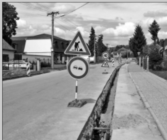
Dopravu na Družstevnej ulici riadi prenosná dopravná signalizácia. Rekonštrukcia prívodu plynu a domových prípojek si vyžiadala technický stav, rekonštrukcia by mala byť v tomto mesiaci hotová. Nasledovať bude nový asfaltový povrch komunikácie. Práce financuje SPP (plyn) a TSK (komunikácia).
