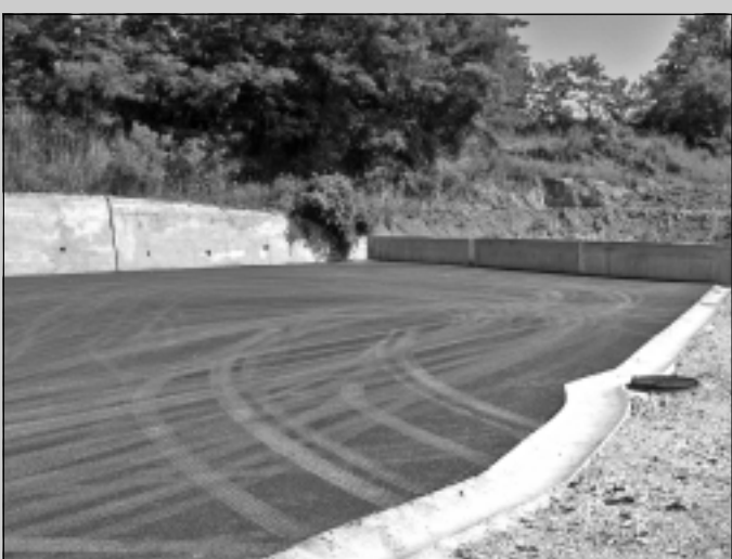
Projekt výstavby kompostárne v areáli bývalej tehelne pokračuje podľa harmonogramu - Spevnená vyasfaltovaná plocha bude slúžiť pre ukladanie biologickej hmoty. Termín dokončenia stavby je tento mesiac. J. Miklaš
