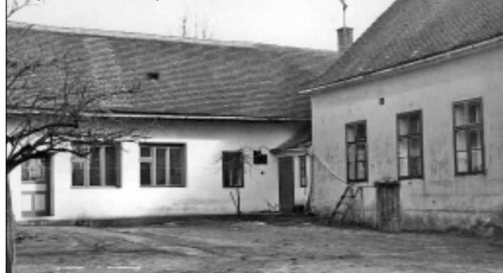
Pohľad z dvora – tretia učebňa adaptovaná z uč. bytu
