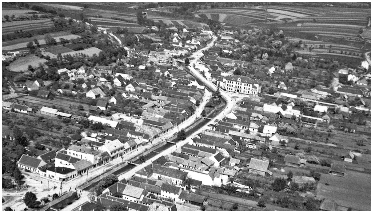
Obr. 3: Pohľad na historickú štruktúru Starej Turej
