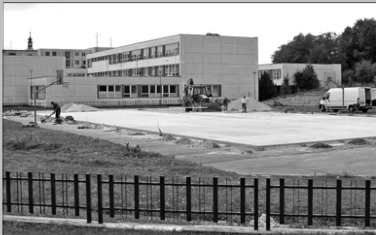
Výstavba viacúčelového ihriska na Hurbanovej ulici - foto J.M.
