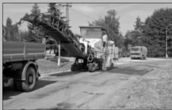
V čase uzávierky časopisu sa na cestách pracovalo. Úprava povrchu po dokončení kanalizácie na Hutskej ceste a rezovanie starého povrchu vozovky na Družstevnej ulici (a nový „kobrec“ na ceste na Paprad) J.M.
