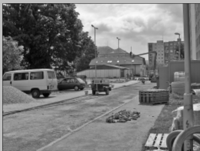
Rekonštrukciou plochy pri obytnom dome č. 3265 na Ul. SNP pribudne parkovacia plocha a na nej 49 parkovacích miest. Ukončenie stavby je plánované do 15. júna 2008. Text a foto J.M.
