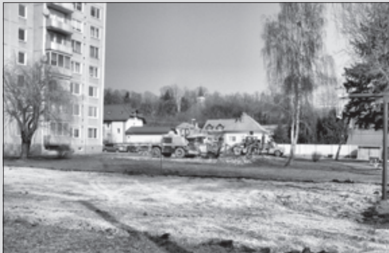
Rekonštrukcia ihriska na Dibrovovej ulici sa už začala (j. m.)
